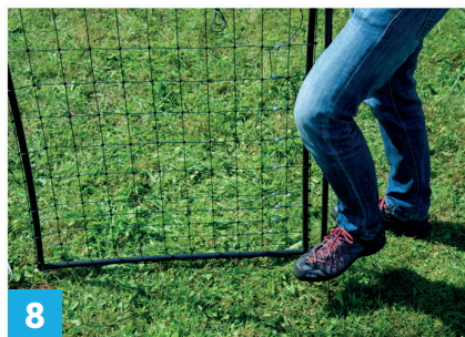
8 Wciśnięcie słupka bramki w ziemię, wokół której obraca się bramka. A kapu oszlopának a földre nyomása, amely körül a kapu forog
